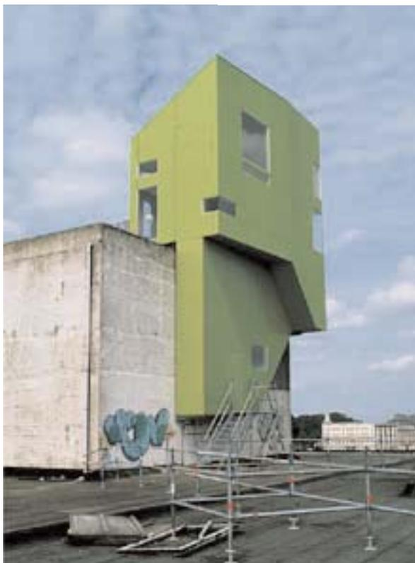
In alto, il Prototipo *Parasite Las Palmas*, Rotterdam, Korteknie en Stuhlmacher architecten, una mini costruzione disponibile a diverse forme d'uso, montata sulla cima di Las Palmas, un vecchio edificio industriale sul porto di Rotterdam. Il nuovo corpo estraneo si impossessa dell'energia dell'ospite collegandosi agli impianti della struttura esistente. Grazie alla sua forma modulare può essere collocato su qualsiasi edificio, da cui il nome di *Parasite*.
